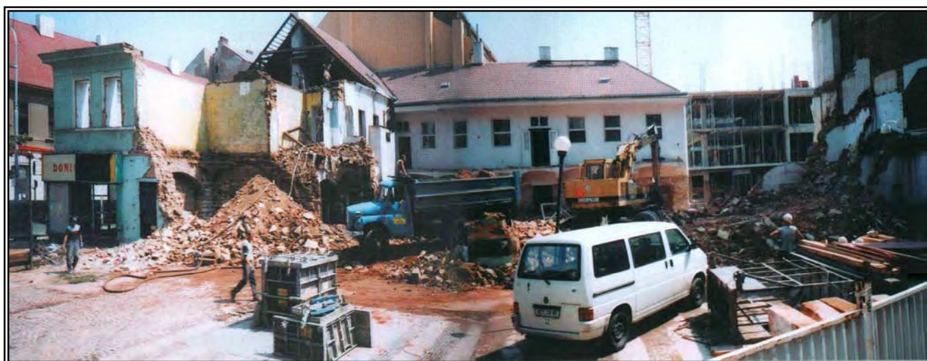
57. DEMOLICE KULTURNÍ PAMÁTKY V ČERVENCI 2003
