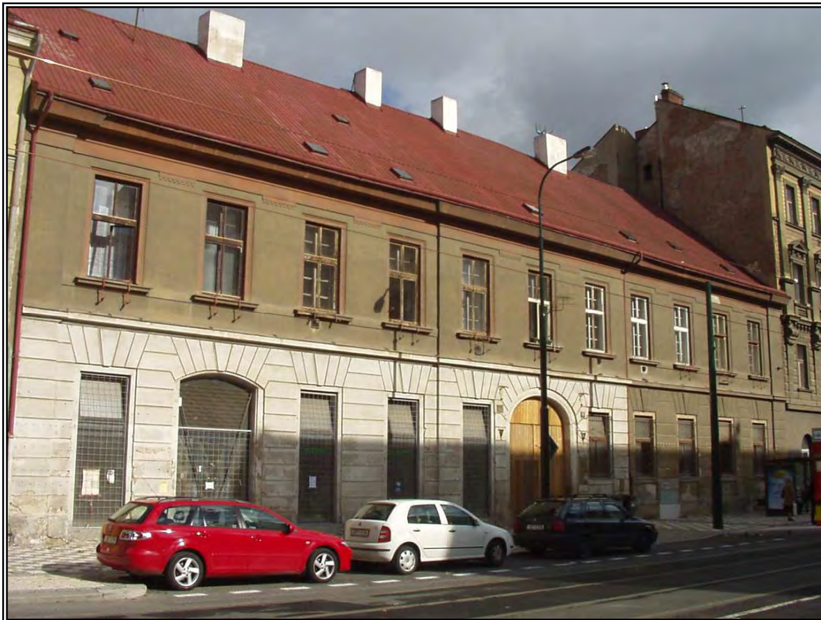
62. DŮM ČP.88 V SOKOLOVSKÉ ULICI, ZAPSANÝ NA SEZNAMU KULTURNÍCH PAMÁTEK Stav v únoru 2004
