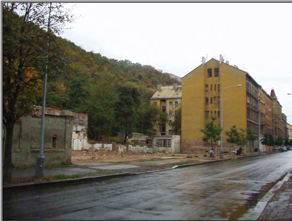
60. LUKRATIVNÍ STAVEBNÍ PARCELA, UVOLNĚNÁ PO DEMOLICI DOMU ČP.9
