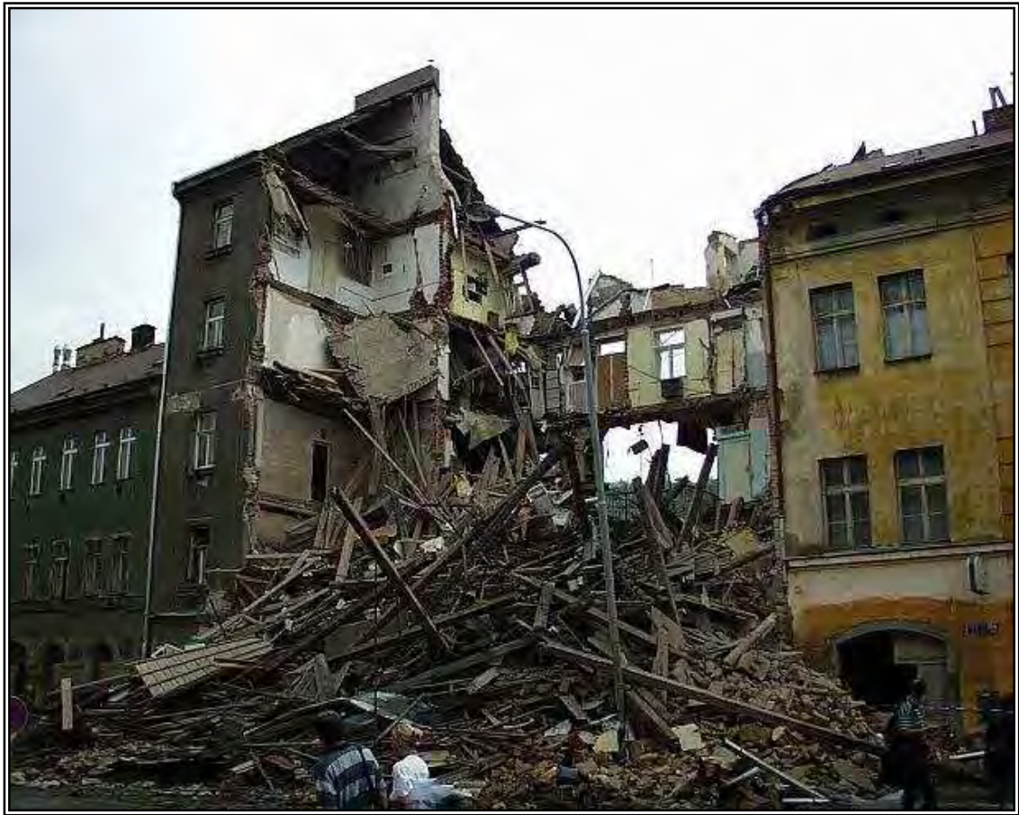
52. DŮM ČP.148 V KŘÍŽKOVĚ ULICI, KTERÝ SE ZŘÍTIL VE 13:13 DNE 15. SRPNA 2002
