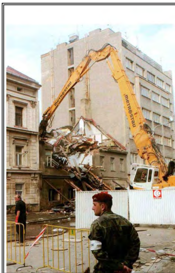
61. DEMOLICE DOMU ČP.125 V KŘÍŽÍKOVĚ ULICI Září 2003
