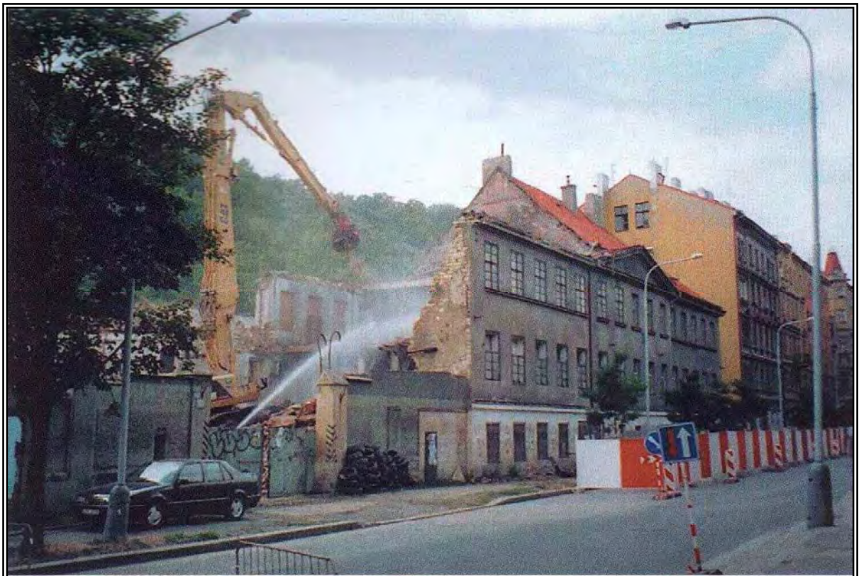
59. DEMOLICE DOMU ČP.9 V PERNEROVĚ ULICI KONCEM SRPNA 2003
