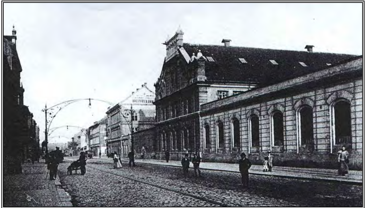
20. TOVÁRNÍ HALA STROJÍRNY BRETFIELD & DANĚK V KŘÍŽÍKOVĚ ULICI (KOLEM ROKU 1900)
